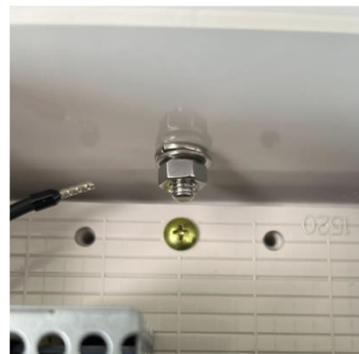
ケーブルグラウンド (S7) のリングを外し、プラボックスの下へ2つ取り付けます。
