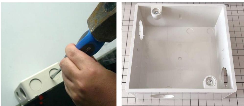
アウトレットボックスの左側と右側にルーバーを取り付けます。ルーバーは雨水侵入防止のため **2 箇所**とも羽板が下向きになるように取付けて下さい。
