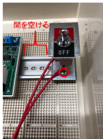
スイッチ台をレールの端にねじ留め
