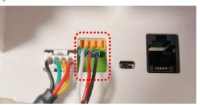
オレンジの爪をドライバ等で押しながら、端子を接続します。接続後、軽くひっぱっても抜けないこと を確認してください。
