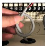
延長ケーブルの赤線を端子台下段右から 11 番目に接続します。延長ケーブルの白線を端子台下段右から 10 番目に接続します。延長ケーブルの黒線を端子台下段右から 9 番目に接続します。軽く引っ張っても取れないことを確認してください。
