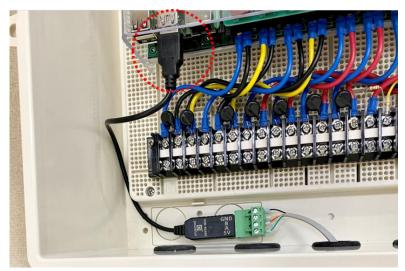
以上で簡易外気象センサの取り付けが完了です。
