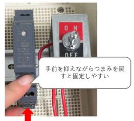
次に電源スイッチの配線を端子台と AC アダプタに接続します。
